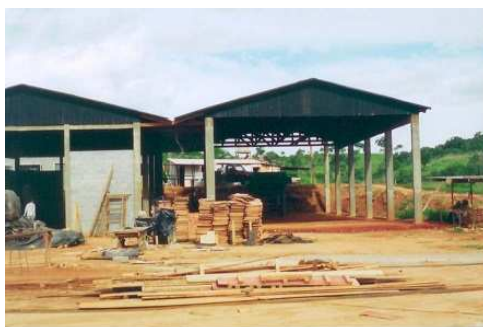
FIGURA 39. Construção da Usina de Reciclagem
