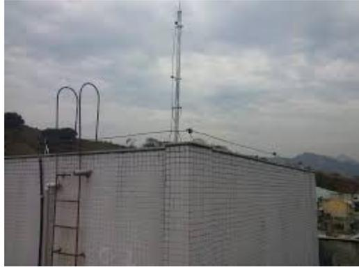
Fig.07- Sistema de SPDA com captor
