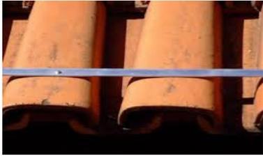
Fig.06. Fita metálica como captor
