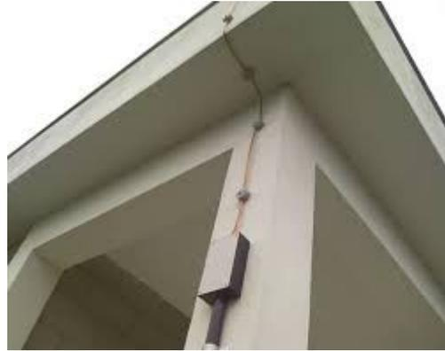
Fig.13- Descida de aterramento com fixação na estrutura
