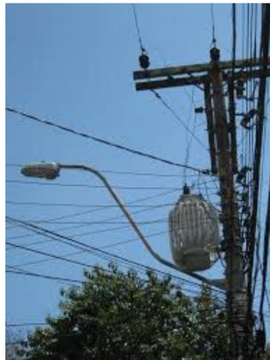
Fig. 28- Transformador trifásico em instalação urbana
