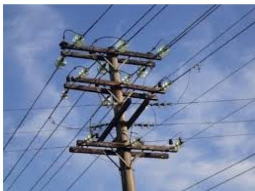
Fig.40-Estrutura em zona urbana para distribuição em 138kV
