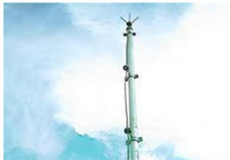
Fig.05-Captor Franklin com cabo de descida de isoladores
