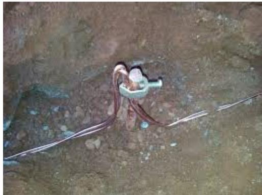
Fig.03-Conexão cabo haste em uma malha de terra
