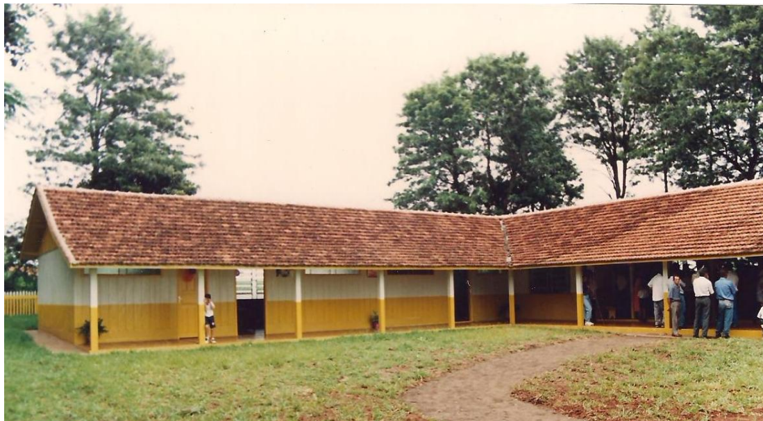
Imagem 8 – Escola Rural Municipal Acre, depois da ampliação e reforma (1995)
