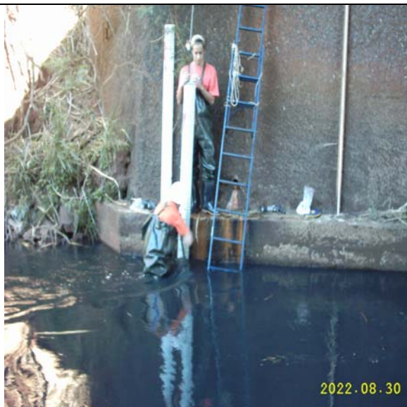
Figura 10 - Instalação de régua no curso médio do Ribeirão Maringá - seção 4
