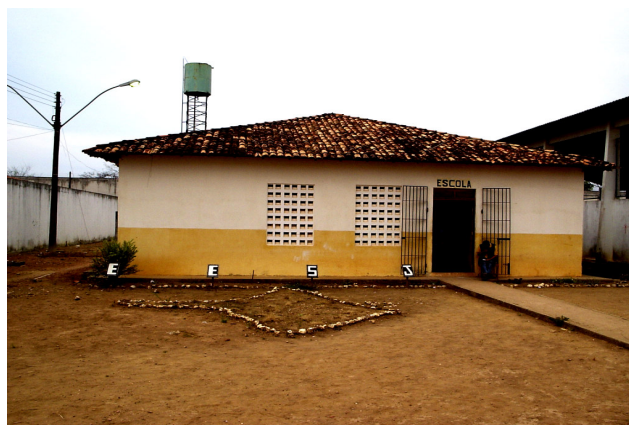
Figura 5 - Escola Estadual São José. Vista de frente:
