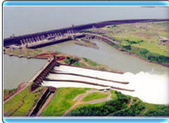
Foto 6. Hidrelétrica de Itaipu.
