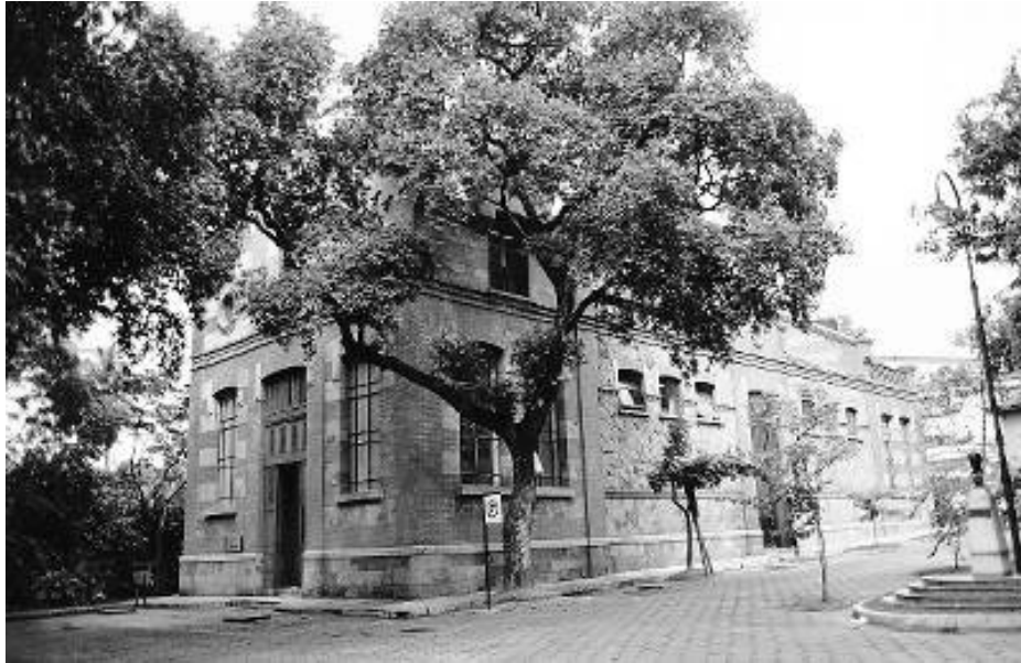
Fachada da cavalaria, construída no início do século, que hoje abriga o Espaço BIODESCOBERTA.
